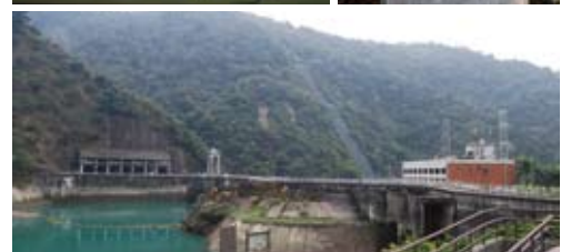
大観発電所 上池と下池の高低差310m
